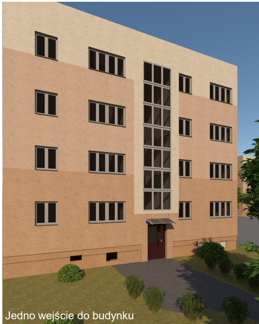
Dobudowany szzyb z zachowaniem wejścia
