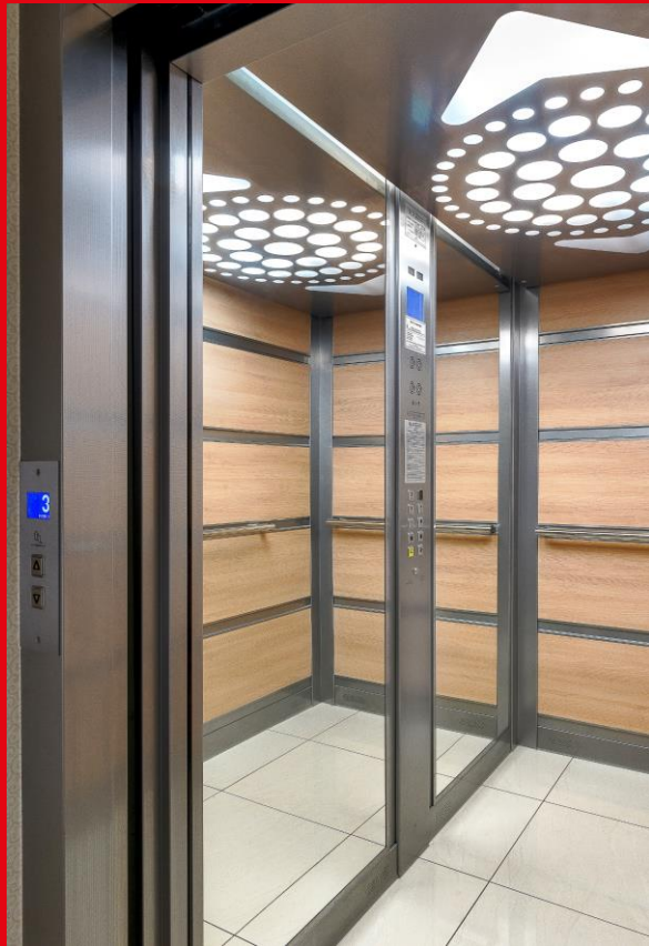
W BUDYNKACH BIUROWYCH
